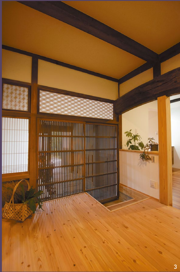
1_ 部屋を細かく仕切っていた壁やふすまを除いて、開放感あるリビングに。状態の良かった柱や床・天井はそのまま使用。2_ 住まいの反対は草の生い茂った急斜面になっているため、カーテンは設置せずあえて草のグリーンを見せることで、空間にさらなる開放感と色彩のコントラストをプラス。3_ 格子の引き戸や組子細工の欄間が、和の趣をさらに演出。
